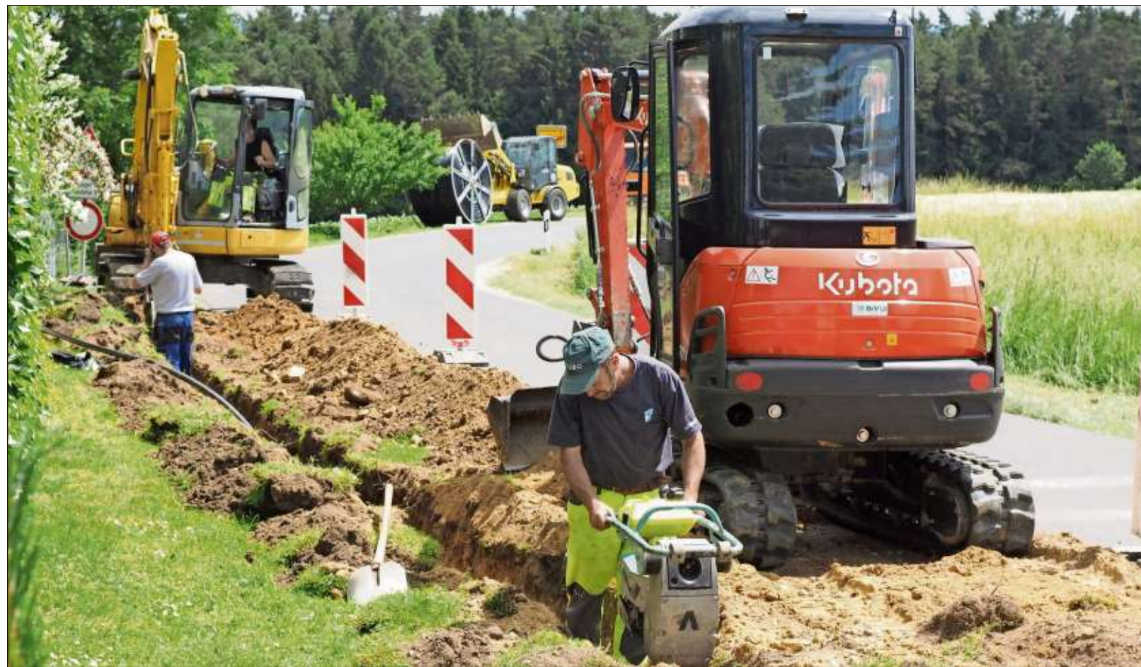
In den vergangenen Jahren lief der Ausbau des Breitbandnetzes fürs schnelle Internet. Nun werden auch entlegene Bereiche ans Glasfasernetz angebunden. Das Bild zeigt eine Kabelverlegung bei Neudorf/Pegnitz. Foto: Archiv/Ralf Münch
